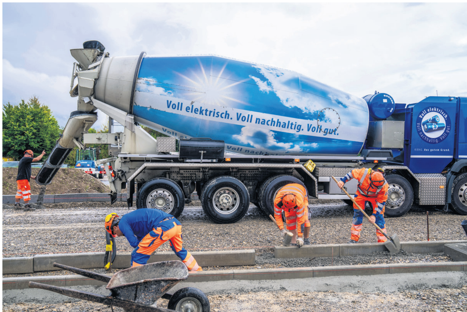
Mehrere elektrisch betriebene Betonmischer sind für die Kibag unterwegs. Bilder: zvg
