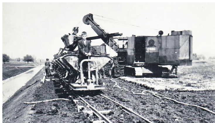
Diesen elektrisch angetriebenen Bagger verwendete die Kibag während des Zweiten Weltkriegs bei der Linthmelioration, als Treibstoff knapp war.
