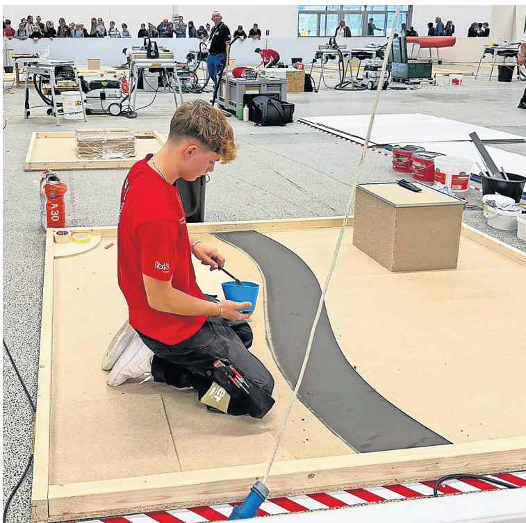
Vorarbeiten und das Höhengspachteln für schwellenlose Übergänge zwischen den Bodenbelägen.
