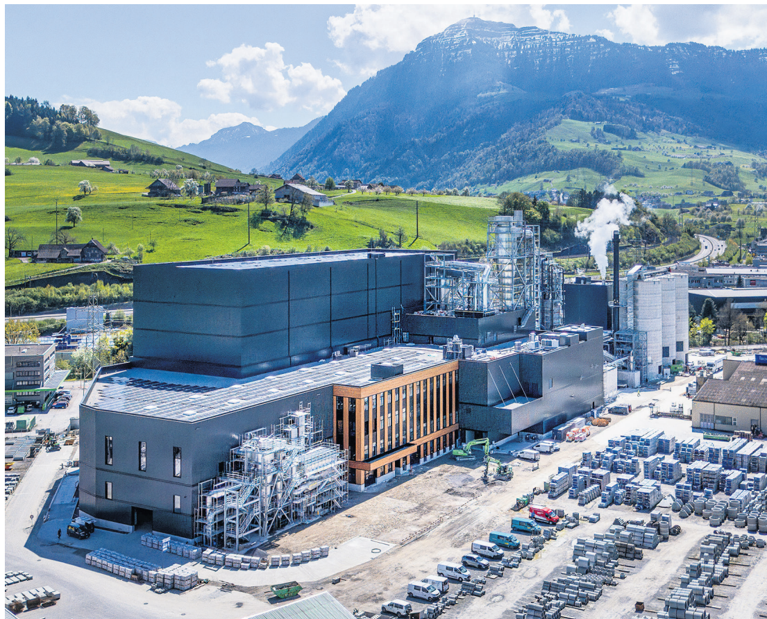
Schilliger Holz baut in Küsnacht ein Holzfaserdämmplattenwerk. Die schweizweit grösste Sägerei schafft damit rund 50 zusätzliche Arbeitsplätze vor allem in der Produktion. Bild: zvg
