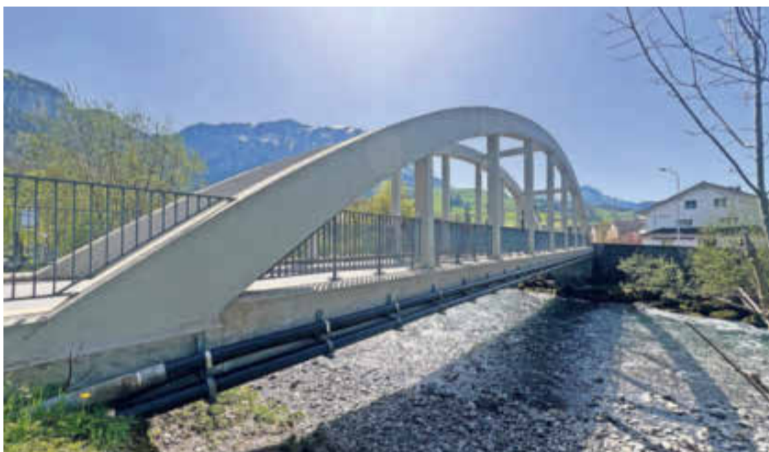
Die Hintere Muotabrücke wurde 1911 erstellt. Die Traglast soll von 3,5 auf 7,5 Tonnen erhöht werden. Für die Sanierung ist eigens ein Hochwasserschutzkonzept erstellt worden. Bild: Andreas Seeholzer
