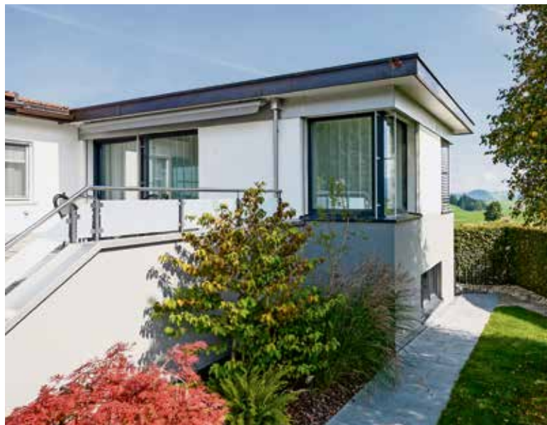
Einbrüche werden häufig über Fenster im Erdgeschoss ausgeübt. Bilder: PD
