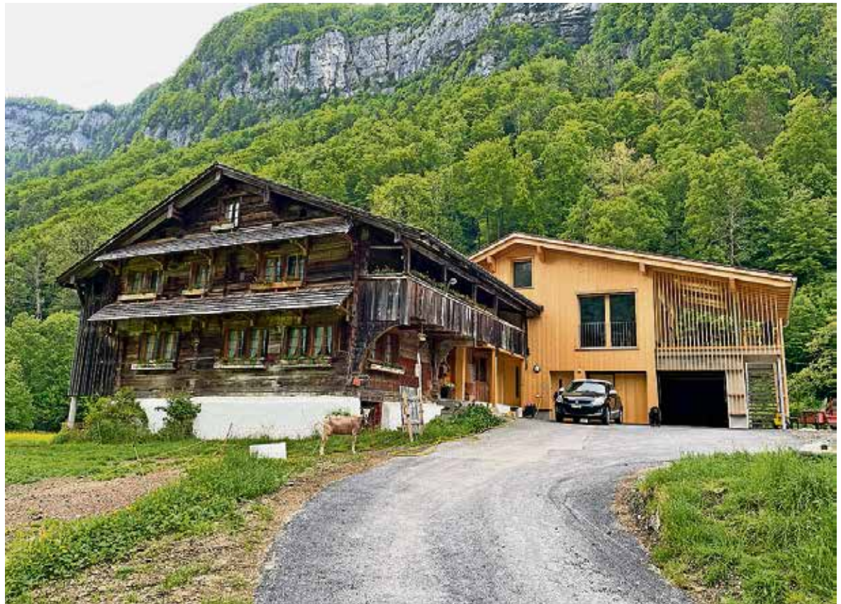
Eine besondere Herausforderung war der Bau der rollstuhlgängigen Garage.
